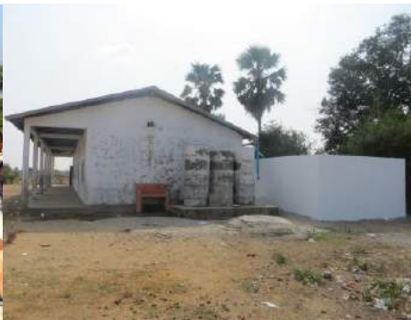
貯水タンク完成
