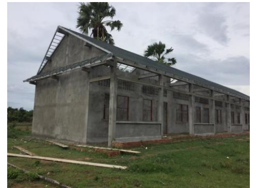
屋根の土台完成
