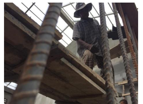
作業風景、セメントで覆う
