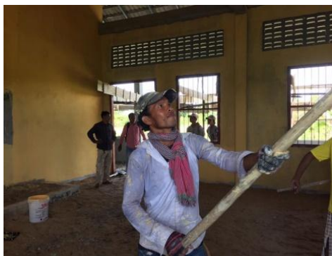
作業風景、内装
