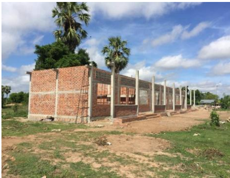
煉瓦で外壁を建てる
