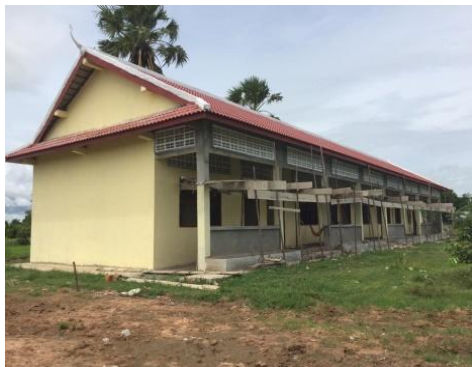
外壁塗装完成
