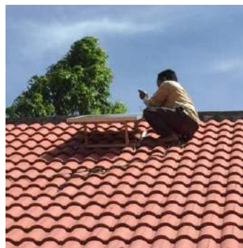
太陽光パネル設置
