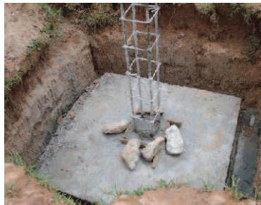
基礎に鉄骨・コンクリートを流しこみ支柱を立てていく
