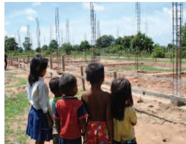
支柱を軸に木枠にコンクリートを流しこみ柱にする
